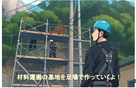
バルブ取替工事
