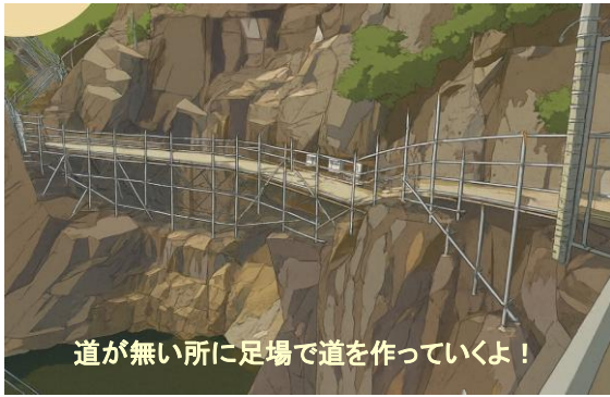
バルブ取替工事
