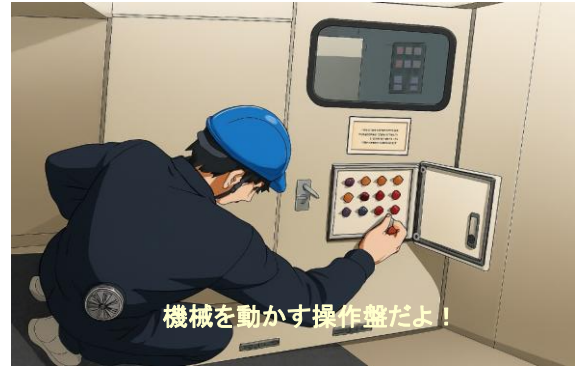
操作盤 点検状況
