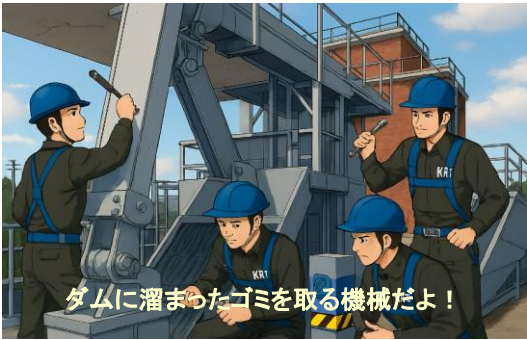
除塵機 点検状況
